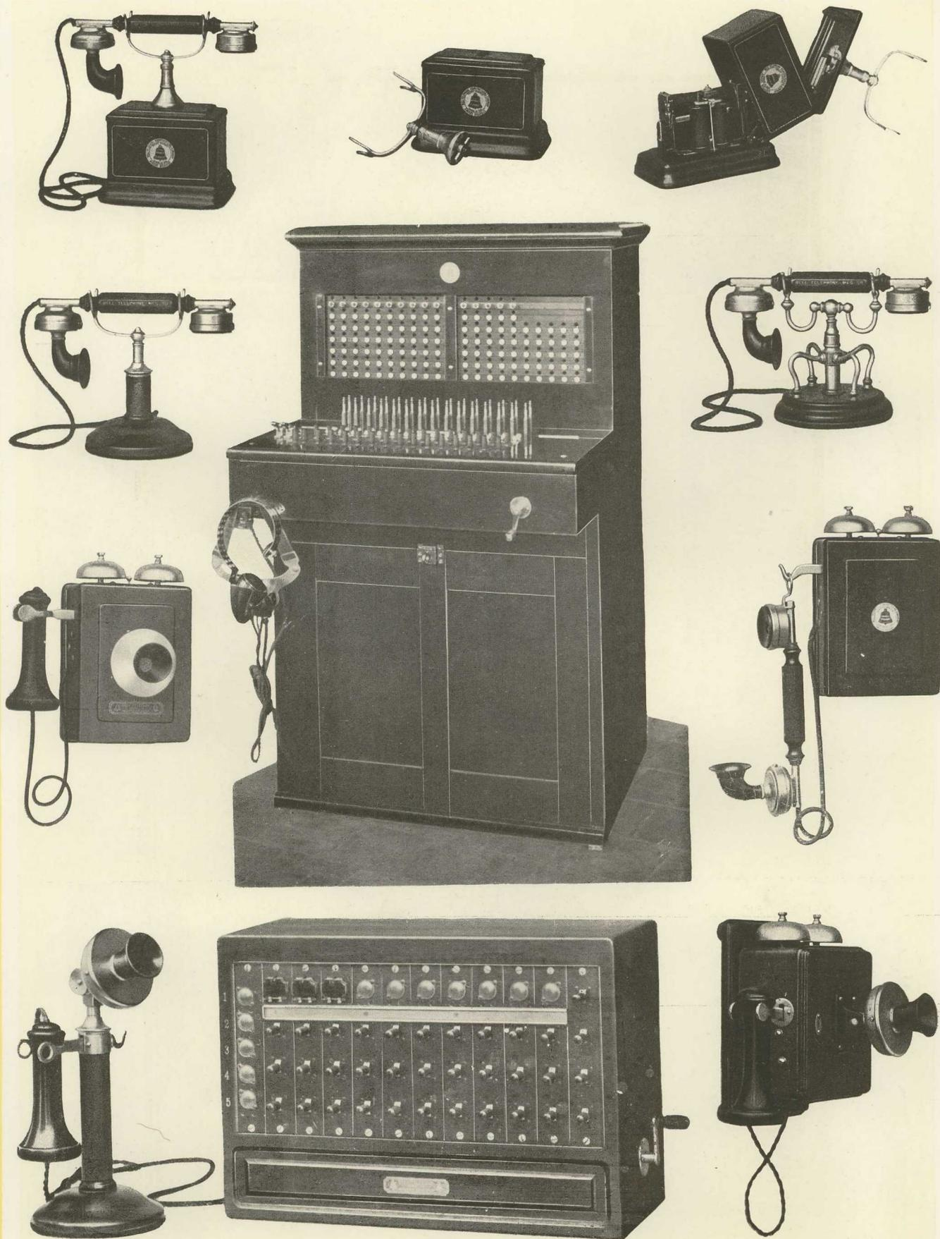
Quelques types caractéristiques d'appareils pour installations à Batterie Centrale.
