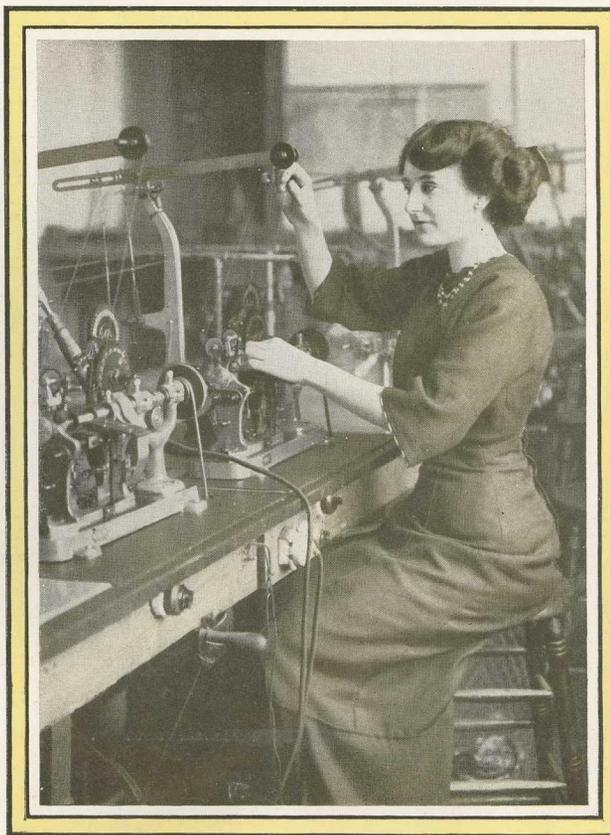
Opératrice sur machine à bobinage automatique.
